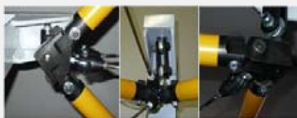
Detail zavesenia tensegrickej jednotky
