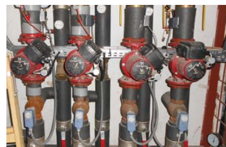
Obr. 2 – Rozdeľovač a zberač pre 1. tlakové pásmo
