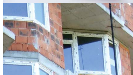
Obr. 4 a 5 – Čierne jadro na povrchu tehliarskych tvaroviek
